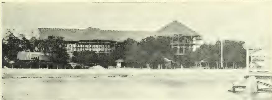
Fig. 74. — Ko Sichan. Palais en bois de teck, en construction, 1892.
